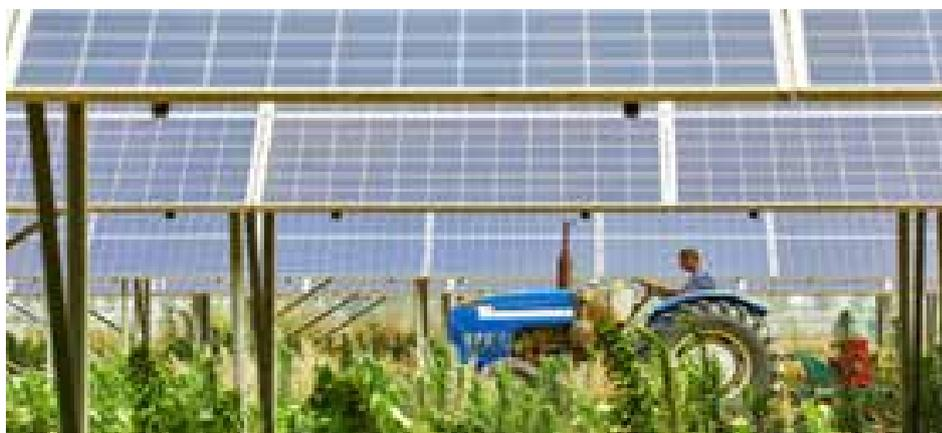
terreno contribuirà a un significativo risparmio di acqua per l'irrigazione, specialmente durante la stagione estiva. L'impianto sarà inoltre dotato di un sistema di sensoristica avanzata per monitorare le condizioni climatiche e agricole in tempo reale. Questo permetterà di ottimizzare sia la produzione di energia che la gestione delle colture, garantendo un uso più efficiente e sostenibile delle risorse naturali.
